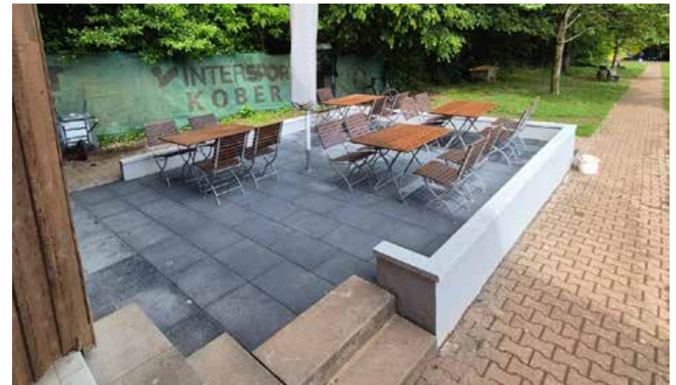
Neue Terrasse auf Tennisanlage
